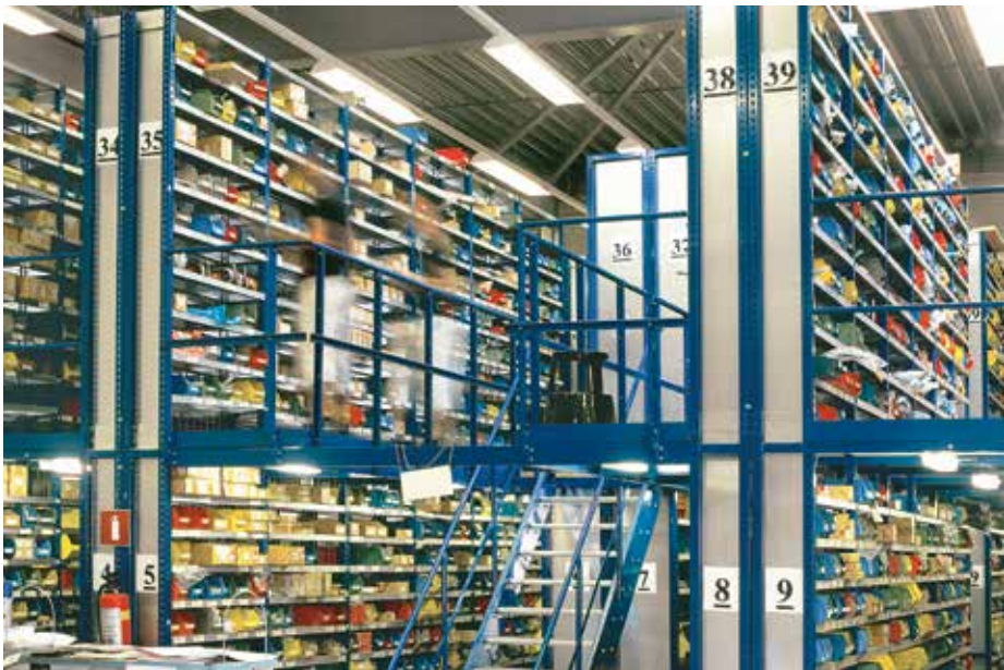
Bild 14-2: Mehrgeschossige Regalanlage mit Absturzsicherung
