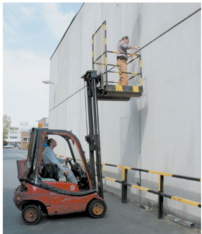
Bild 8-2: Gabelstapler mit Arbeitsbühne
