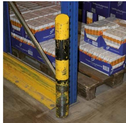
Abb. 14 Besonders stabil ausgeführter Anfahrerschutz
