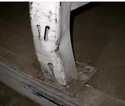
Abb. 12 Gerissene Schweißnaht an der Fußplatte der Stütze
